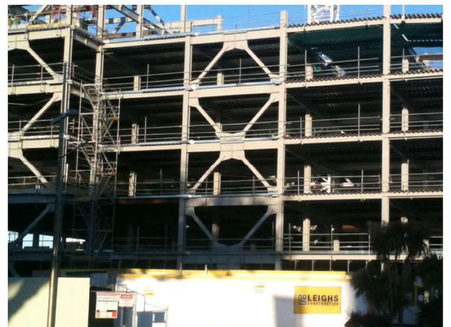
**Exemple de dispositif de renforcement parasismique.**
