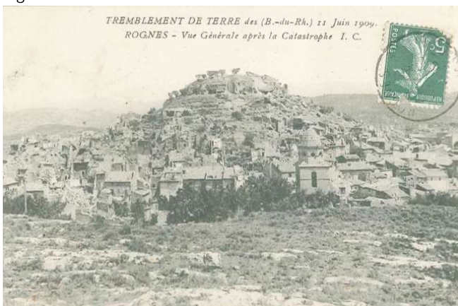
Exemple d'effet dû au relief : la ville de Rognes, construite sur un relief marqué, présenta des dommages plus importants en son sommet lors du tremblement de terre de Lambesc 1909.
