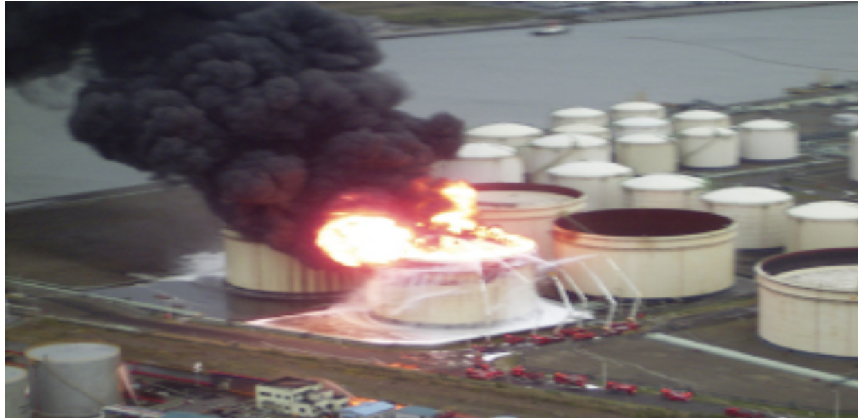
2003年 十勝沖地震により苫小牧市の製油所で発生したナフサタンクの全面火災 Full-surface fire in an oil refinery's naphtha tank in Tomakomai after the 2003 Tokachi-oki earthquake
