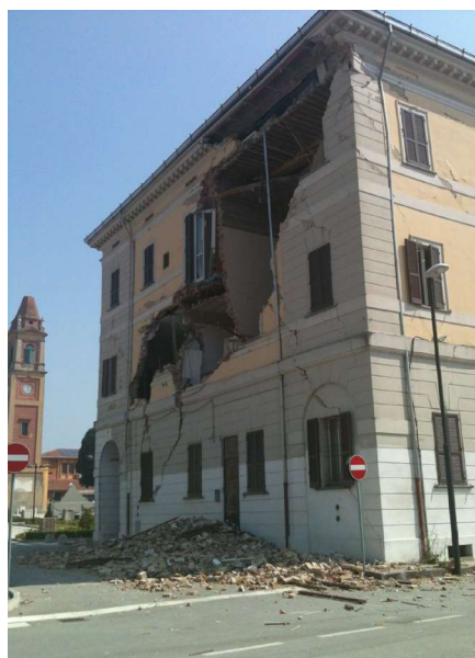
Séisme d'Emilia Romagna (Italie, 2012) . Exemple de dommages observés pour un séisme de magnitude modérée (M=6) sur des bâtiments industriels et historiques.
