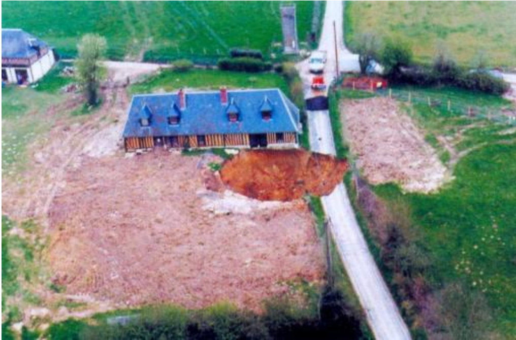
Effondrement d'une marnière le 31/03/2001 à 22h45, faisant une victime, surprise sur le pas de sa porte (Neuville-sur-Authon, Eure) (archives protection civile 27)
