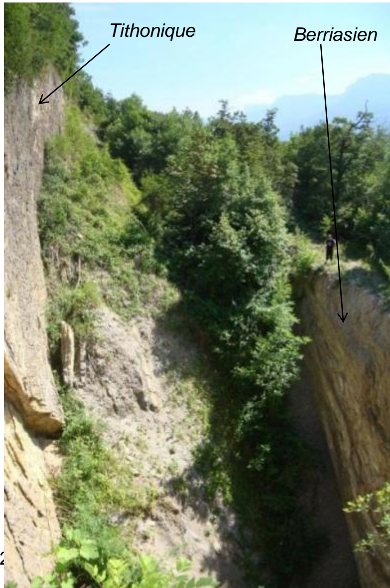
Effondrement de 1987, réactivé en 2011
