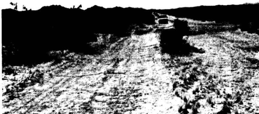
*Figure 1 – Un exemple de trace d'un séisme en surface : une route à deux voies a été décalée latéralement d'environ six mètres pendant le séisme de Landers en Californie du Sud en 1992. La rectitude de la route montre que le glissement se produit sur une zone très étroite. (Photo M. Campillo.)*
