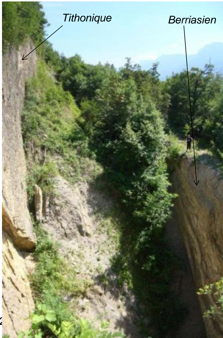
Effondrement de 1987, réactivé en 2011
