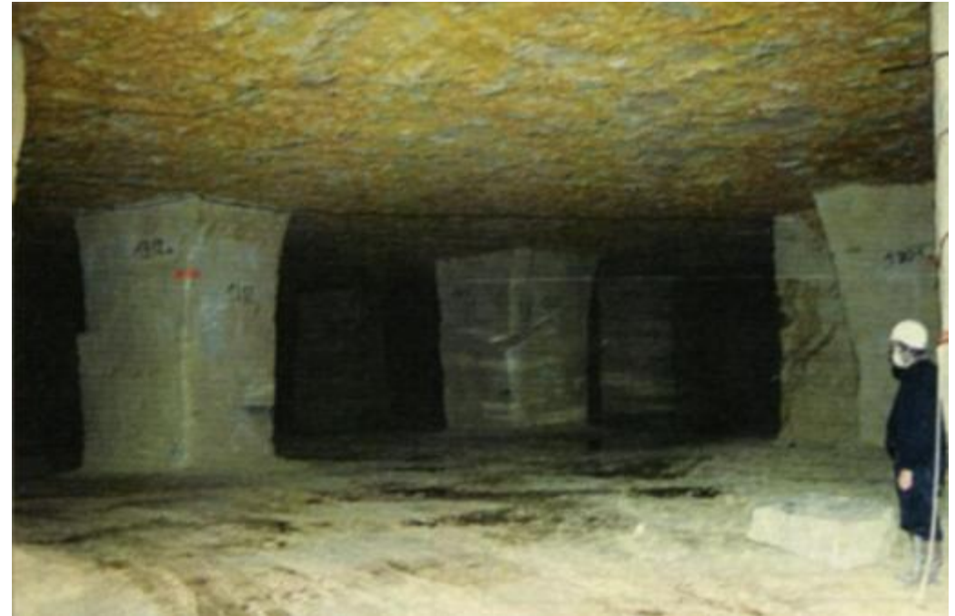
Carrière de calcaire exploitée par chambres et piliers (carrière de la Maladrerie à Caen). ( extrait de Evaluation des aléas liés aux cavités souterraines, INERIS, LCPC )
