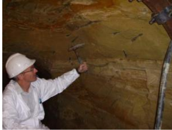
Renforcement des galeries dans les zones sensibles
