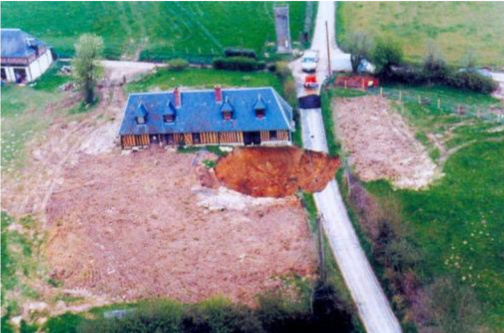
Effondrement d'une marnière le 31/03/2001 à 22h45, faisant une victime, surprise sur le pas de sa porte (Neuville-sur-Authon, Eure) (archives protection civile 27)
