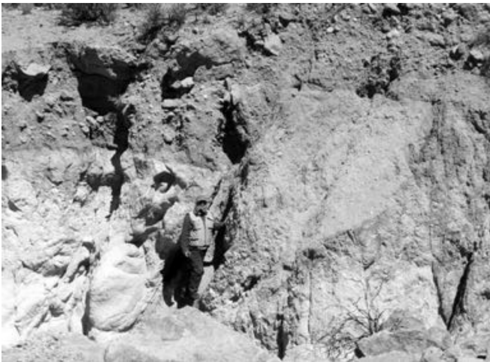
FIG. 5.2.4.2. Falla San Francisco afectando a tobas miocenas y a depósitos coluviales recientes. (Foto: Ramírez, 2007).
