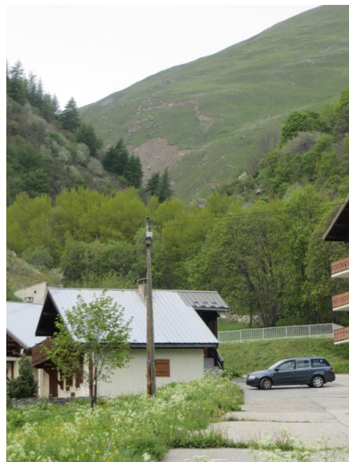
Photo du glissement de terrain prise depuis le hameau des Verneys
