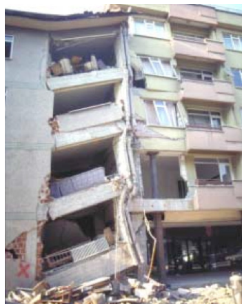
Exemple de dommage dû à l'environnement. Chocs entre deux bâtiments adjacents.
