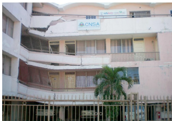
Exemple de dommage dû à l'irrégularité en plan. Structure irrégulière de forme.
