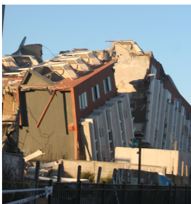
Exemple d'une construction en béton armé endommagée lors du tremblement du Chili (2010). Même en béton armé, un mauvais respect des règles de conception entraîne la destruction complète de la structure.
