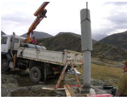
Figure 1-12 : installation de la station ALPE (Alpe d'Huez) : 1- ferraille scellée dans le rocher et coffrage pour la base ; 2- pilier réalisé en béton dans un coffrage carton cylindrique ; 3- pose d'une buse (canalisation en béton) protectrice par-dessus le pilier ; 4- installation d'un coffret pour le récepteur et du panneau solaire, pose de l'antenne sur le pilier.
