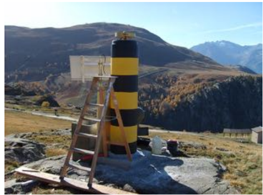
Figure 1-12 : installation de la station ALPE (Alpe d'Huez) : 1- ferraille scellée dans le rocher et coffrage pour la base ; 2- pilier réalisé en béton dans un coffrage carton cylindrique ; 3- pose d'une buse (canalisation en béton) protectrice par-dessus le pilier ; 4- installation d'un coffret pour le récepteur et du panneau solaire, pose de l'antenne sur le pilier.
