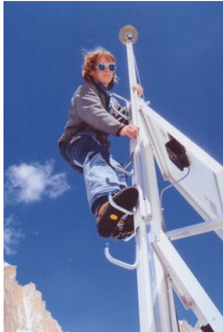
Figure 1-09 : installation de l'antenne GNSS sur un mât « planté » dans la glace (photo : L. Ott, glacier d'Argentière, 2008).
