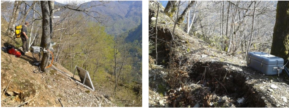
Figure 7. Photographies de la balise GPS-RTK : à gauche après son déplacement en avril 2013 à proximité de la cible radar 1803, à droite en janvier 2014. On observe l'ouverture d'une fracture majeure.
